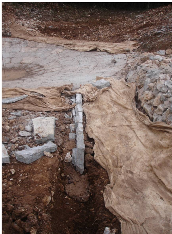
La rigole utilise les restes d'argile et de dalles non consommés
