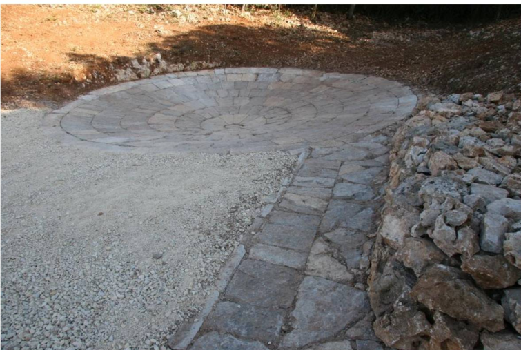
L'appareillage de la rigole
