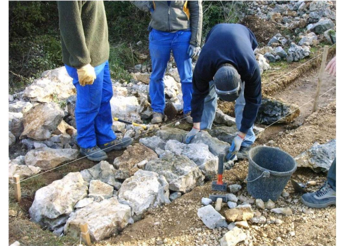
Construction de l'assise
