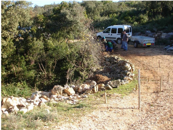
Piquetage de l'emprise du muret à bâtir
