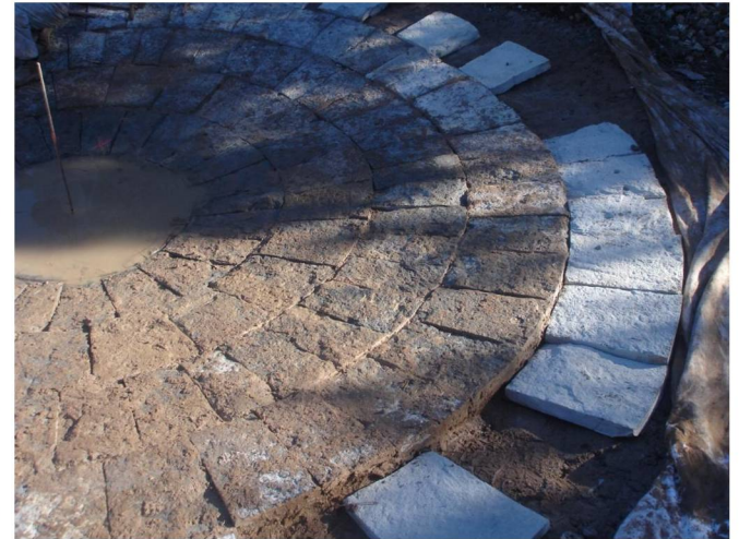
6 ème rang. Les dalles de la nouvelle rangée ne sont pas encore calées à l'argile
