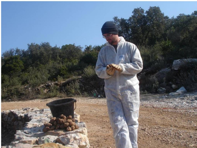
Préparation des boules d'argiles qui seront utilisées pour caler les dalles (rattrapage des niveaux)
