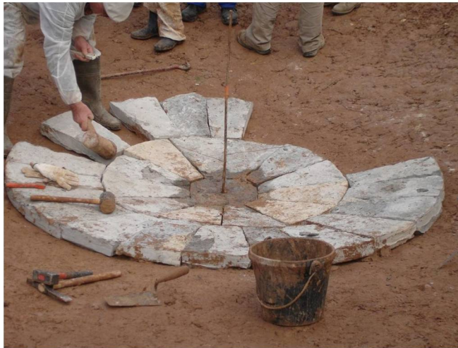
Construction du second rang. Les maillets en bois permettent d'exercer des pressions sur les dalles sans éclater la pierre
