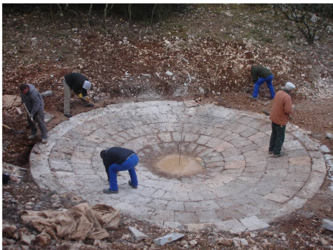
Les sept rangées de dalles sont posées. On prépare le dernier sillon pour finir le bâti avec des petites pierres
