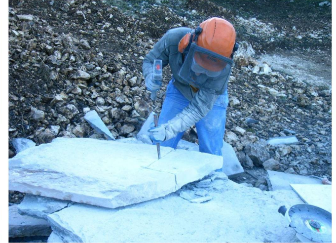
Finition d'une dalle à l'aide d'une chasse à pierre
