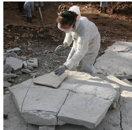
Illustration d'un tracé de coupe à l'aide d'un gabarit
