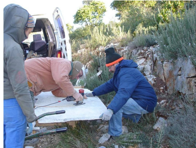
Découpe à la scie sauteuse d'un gabarit en contreplaqué
