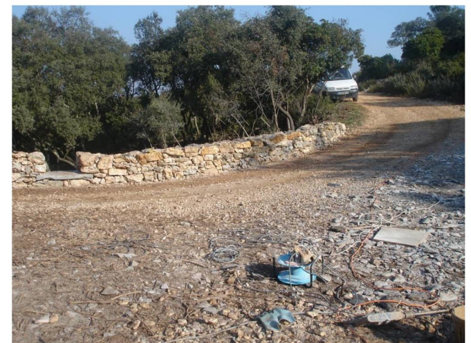
Le muret terminé. Il reste à rehausser la piste jusqu'à hauteur du passage d'eau avec du tout-venant (15 m3)
