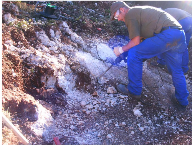
Utilisation du marteau burin sur les parties rocheuses
