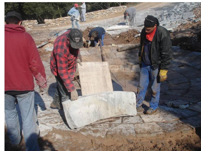
Mise en place de la dernière rangée de dalles. Ces dalles sont les plus imposantes afin de verrouiller le bâti et d'éviter le fousissement des sangliers attirés par l'argile
