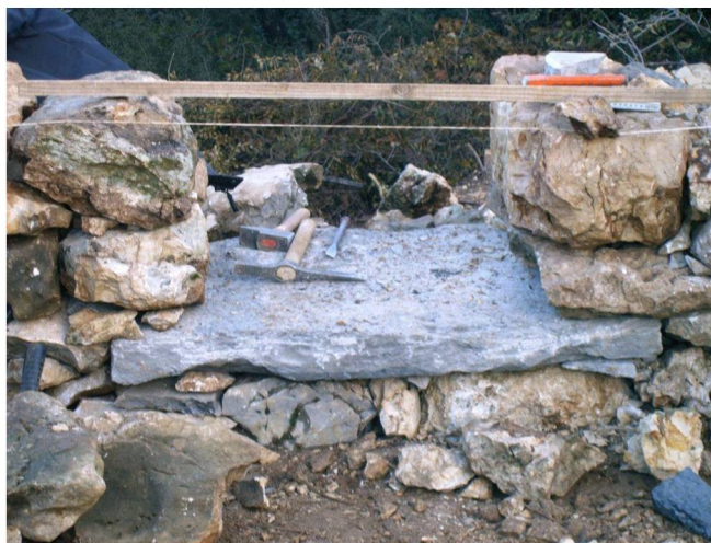
Détail du passage pour l'évacuation de l'eau en cas de trop plein
