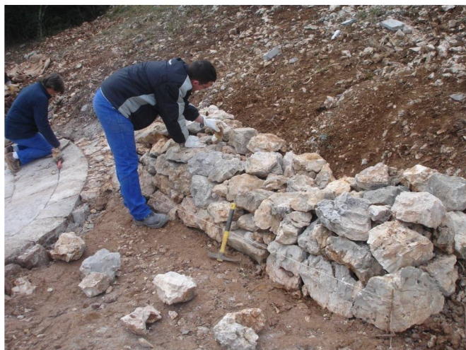
Construction du second muret
