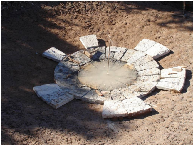
Construction du 3 ème rang. Un peu d'eau est présent au centre de l'ouvrage suite à une petite pluie
