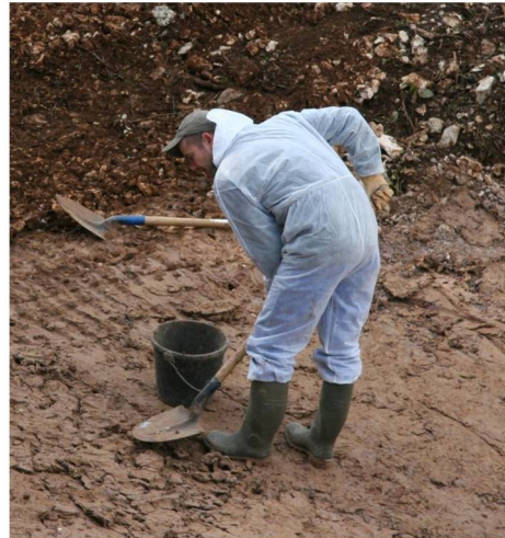
Le façonnage manuel de l'argile se fait avec du petit outillage (truelles, pelles)
