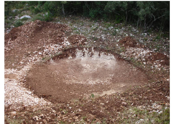
Retrait des pierres de l'emprise de la lavogne
