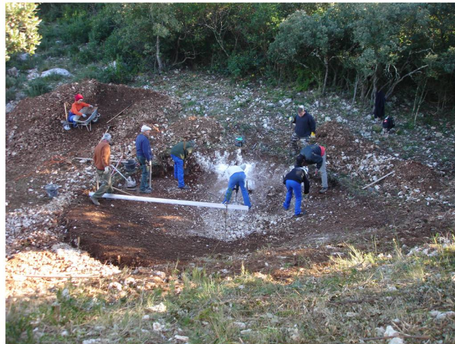
Suivi de la mise en forme de l'assise de l'ouvrage
