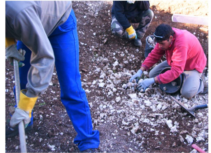
Retrait des pierres de l'emprise de la lavogne
