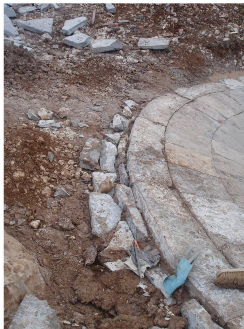
Bordure de pierres sur la périphérie de l'ouvrage. Outre l'aspect esthétique, cette finition participe au verrouillage de l'ensemble du bâti
