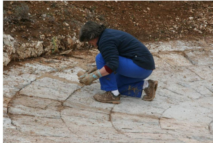
Remplissage des derniers vides entre les dalles à l'aide d'argile liquide pour garantir l'étanchéité de l'ouvrage
