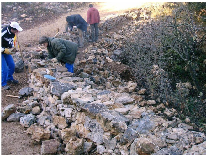
Le muret en construction
