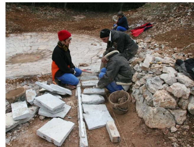
Construction de la partie centrale de la rigole avec des dalles posées à plat
