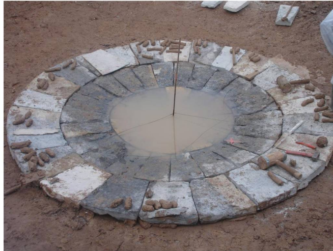
Finition du 3 ème rang par calage à l'aide des boules d'argile
