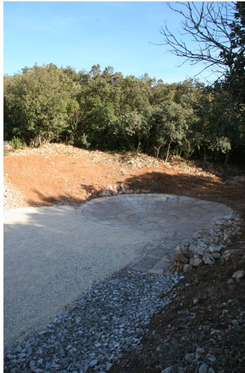
Le fossé prolongeant la rigole est tapissé d'argile et de brisures de dalles, qui contrastent avec la couleur de la piste
