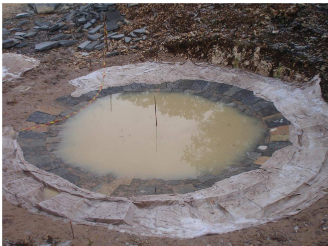
6 ème rang : Suite à un événement pluvieux, la lavogne est en partie remplie. Il faut la vider avec une pompe pour poursuivre les travaux
