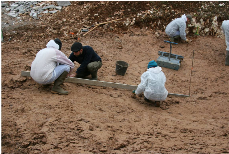
Utilisation d'une règle en aluminium pour vérifier les niveaux
