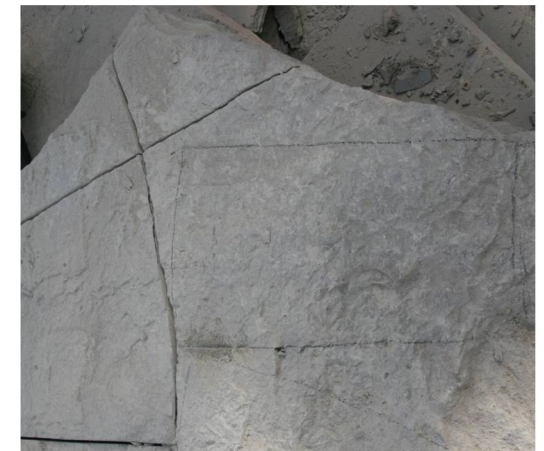
Illustration d'un tracé de coupe à l'aide d'un gabarit
