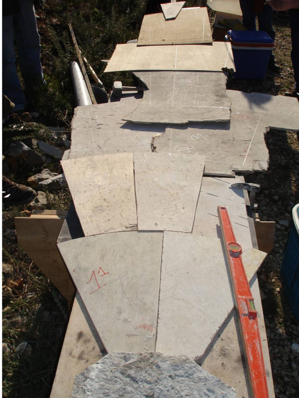
Aperçu des différents gabarits utilisés en fonction des rangs de dalles
