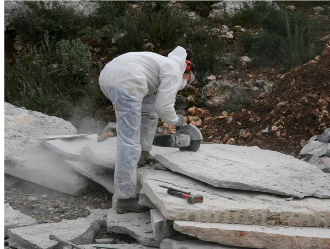
Taille initiale à la disqueuse (la capacité de coupe d'une disqueuse étant inférieure à l'épaisseur des dalles, il faut finir chaque découpe à l'aide d'une chasse à pierre)
