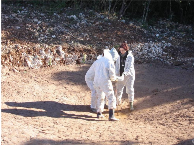
Installation de la pierre centrale. Celle-ci est percée en son centre pour pouvoir passer un fer tord qui servira de référence pour l'appréciation des niveaux
