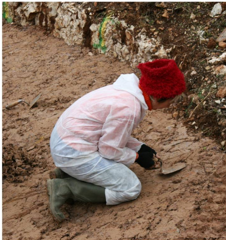
Le façonnage manuel de l'argile se fait avec du petit outillage (truelles, pelles)
