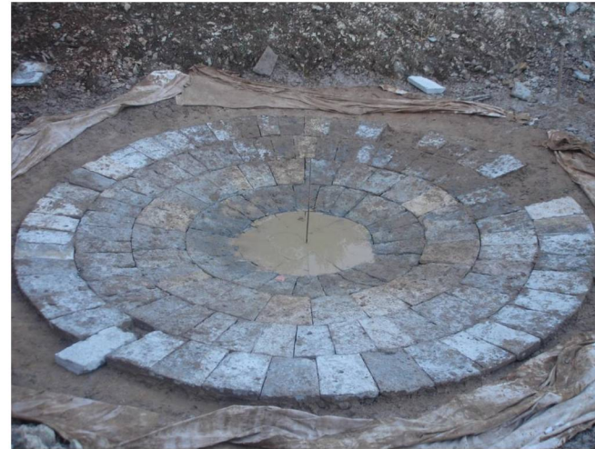
Le 5 ème rang en fin de construction. Les parties non bâties sont protégées par la feutrine
