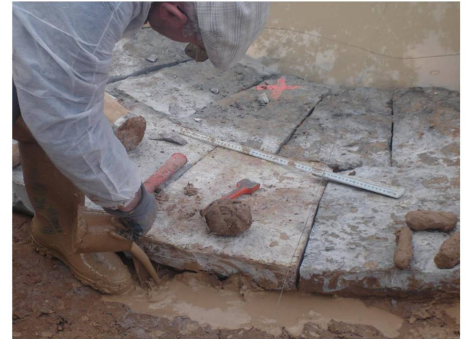
L'utilisation d'argile liquide permet d'atteindre et de combler les vides sous le bâti
