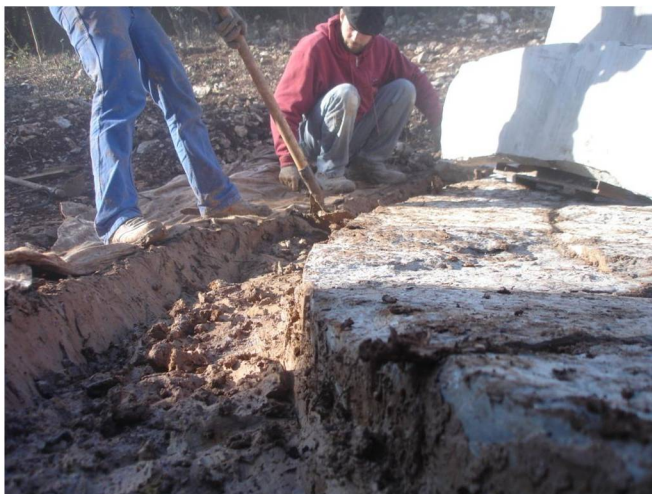
Décaissement pour la dernière rangée de dalles
